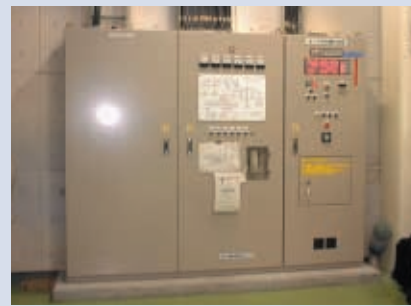
コントロール盤 すべての工程は自動的に制御・監視されるため無人化が可能です。
